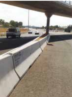
شارع رقم 5 منظومة حواجز مزدوجة. موديل: DB80AS/6M Double Row
