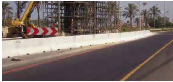
حيفا- المداخل الجنوبية. حاجز مؤقت من أجل تنفيذ اعمال بناء الجسر. موديل: DB80/4M k180 . مستوى الصد: H1
