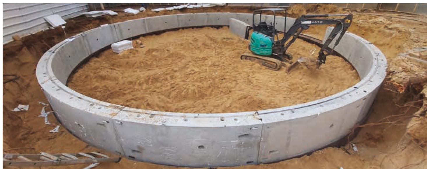
חלקו העליון של הפיר מגיע עם מוביל מתכת CUTTING SHOE המתוכנן על ידי ולפמן תעשיות.
