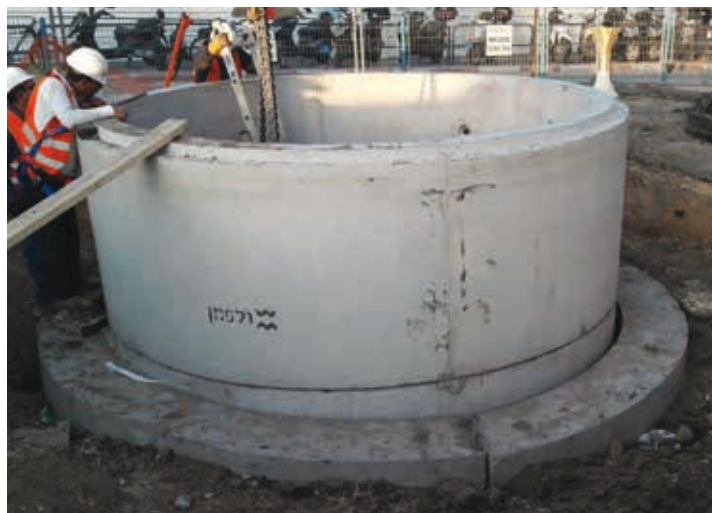
חלקו העליון של הפיר מגיע עם מוביל מתכת CUTTING SHOE המתוכנן על ידי ולפמן תעשיות.
