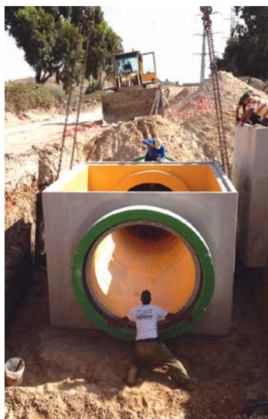
תא בקרה מלבני עם תעלה מוכנה. כל פנים התא מכוסה ב-ליינר HDPE.
