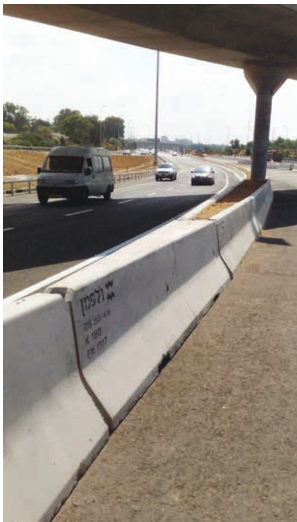
כביש מס' 5, מערכת מעקות כפולה. דגם: DB80AS/6M Double Row
