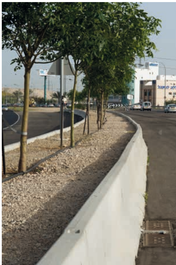
כביש מס' 75 מפרץ חיפה, שילוב צמחיה ושדרת עצים במערכת מעקות כפולה. דגם: DB80AS/6M Double Row
