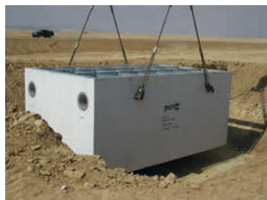
התקנת מפריד דלקים ושומנים מינרליים 303-cmos בנבטים.
