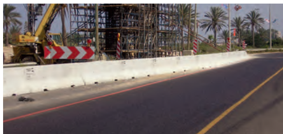
חיפה - מבואות דרומיים. מעקה נייד זמני לצורך ביצוע עבודות בניית גשר. דגם: DB80/4M k180 רמת בלימה: H1.
