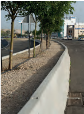
כביש מס' 75 מפרץ חיפה, שילוב צמחייה ושדרת עצים במערכת מעקות כפולה. דגם: DB80AS/6M Double Row
